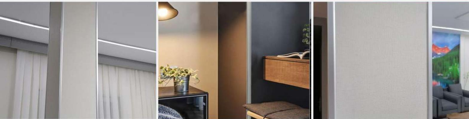
پروفیل های نبشی آلومینیومی با عرض بال های ۱/۵ و ۲ سانت برای پوشش کنج دیوار و پارتبیشن ها و ستون کاربرد دارد و مخصوصا در کنج های کاشی کاری شده و پنجره ها از لب پله شدن کنج ها جلوگیری میشود
