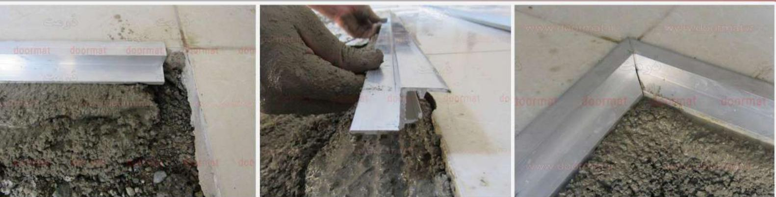
پروفیل آلمینیومی Z برای اجرای توکار پادری های ۲ سانتی با تردد زیاد تولید شده با استفاده از این پروفیل عمق نیاز پادری تامین میشود و از لبه های سرامیک یت سنگ کف نیز محافظت میشود
