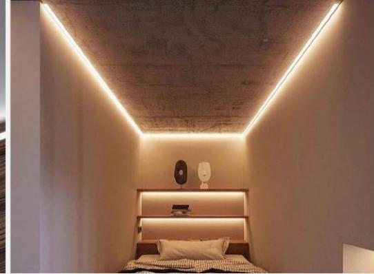
نور خطی با عرض ۲ سانت که به صورت به لبه دار تولیده شده بیشتر برای اجرای توكار مناسب است و با افزایش عمق و استفاده از LED با تراکم مناسب میتوان نور یکنواخت تولید نمود از این پروفیل برای سقف کاذب و ساخت آبازور نیز استفاده میشود از دیگر موارد استفاده این پروفیل میتوان در کف سالن های نمایشی و دیوار ها نام برد
